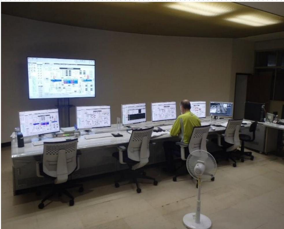
令和2年度に、秋里下水終末処理場の中央監視装置をリニューアルしました。鳥取市が管理する処理場やポンプ場は、秋里で集中監視しており、持続的な下水道サービスの提供ができる体制を取っています。また、異常が生じた際に早急な対応ができる体制としています。
