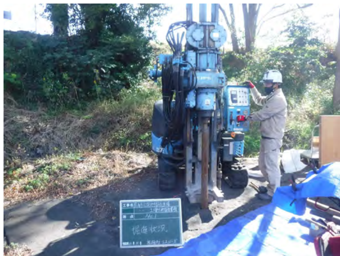
写真-1 エコプローブ (No.1 掘進状況)
