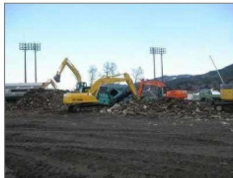
重機による粗選別 （岩手県宮古市宮古運動公園）
