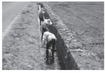
水路の泥上げ
