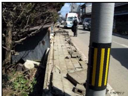
地震で倒壊したブロック塀（出典：（一財）消防防災科学センター）
