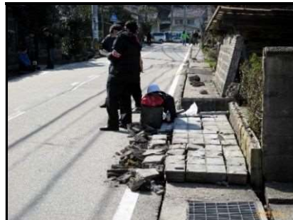
地震で倒壊したブロック塀（出典：（一財）消防防災科学センター）
