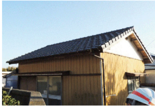
ガイドライン工法の瓦屋根（ほとんど被害なし）
