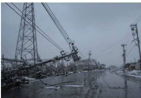
災害による電柱倒壊の事例
