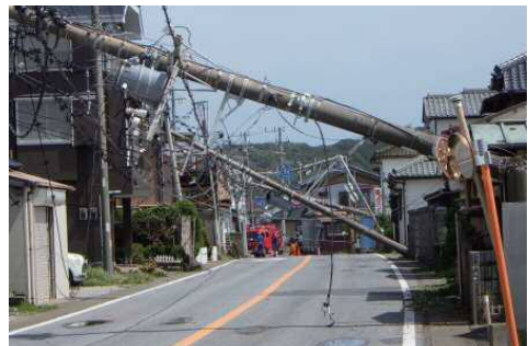
災害による電柱倒壊の事例
