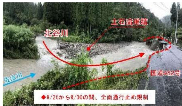
「土砂災害による被害」(R1.9.26)
