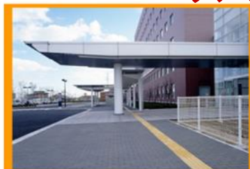
段差がなく、見通しのよいアプローチ通路 視覚障害者誘導用ブロックの敷設
