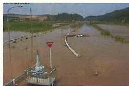
写真33: 以前の塩見川水害状況
