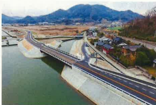
写真3:箭溪川（江川）との合流部の改修状況
