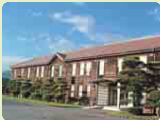
敷地内の建物
