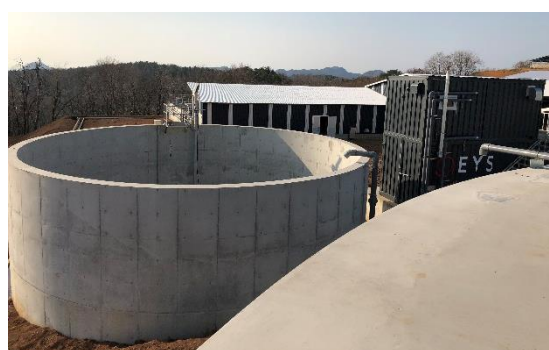
（株）みんなの牧場が運営する牛ふん尿から発生したメタンを活用したバイオマス発電設備
