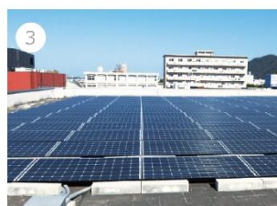
鳥取県立図書館 太陽光発電所 出力:49.5kW
