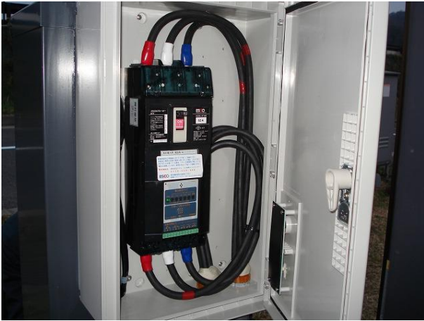
本市が導入し省コストが実現した電子ブレーカー
