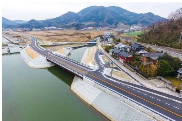
写真3: 箭溪川（江川）との合流部の改修状況
