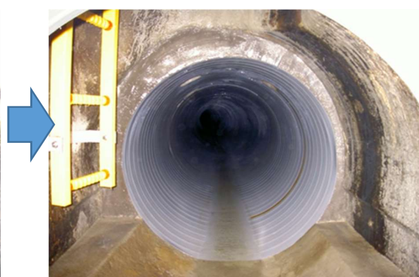
図 27 管更生実施後
