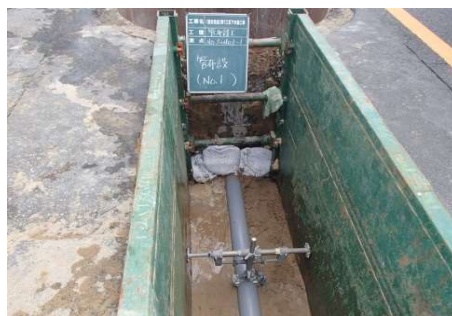
図 23 汚水管の敷設
