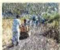
未舗装農道の舗装
