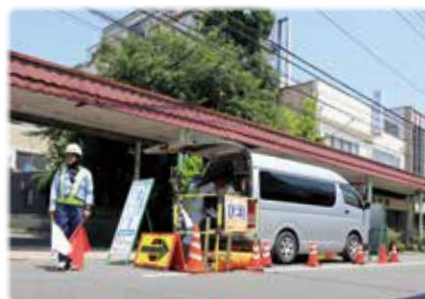
下水道管調査
