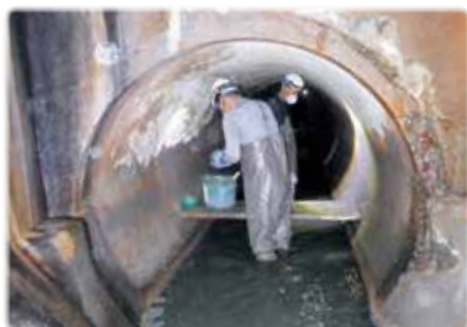
管内での補修作業
