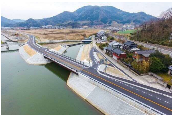
写真3: 箭溪川（江川）との合流部の改修状況
