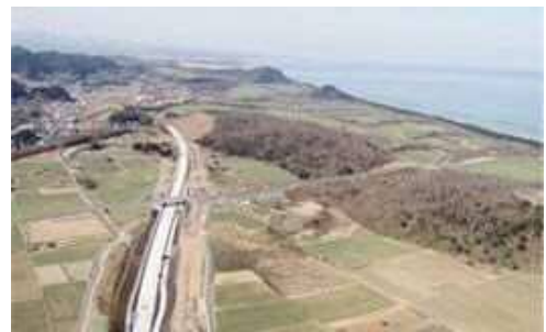
写真1: 山陰近畿自動車道
