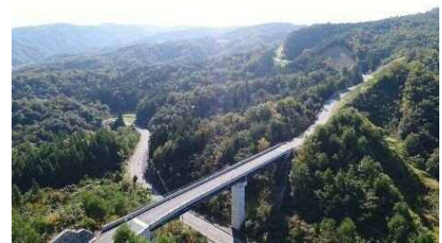
写真2: 岩美広域農道
