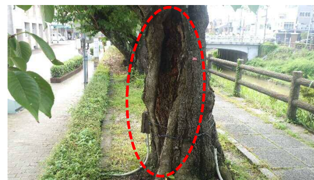
開口し空洞が大きくなったサクラ
