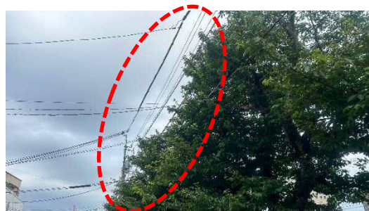
枝の電線干渉状況
