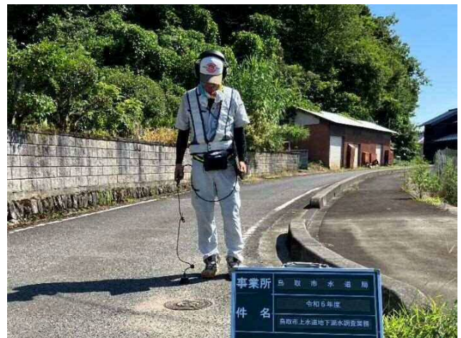
漏水調査状況（音聴調査）
