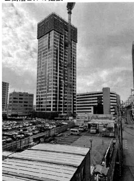
■高層ビルの建設
