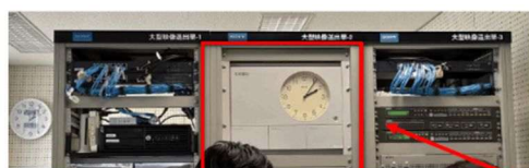
3階放送室:サーバラック内の親時計制御器
