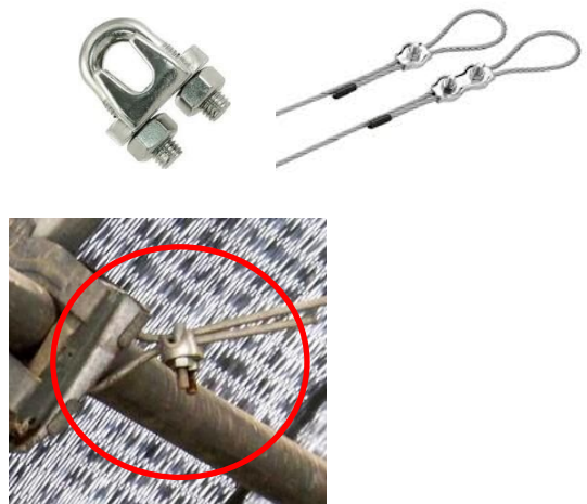
図16 水平引っ張り線による補強の例と番線を留めるワイヤークリップ (群馬県原図を一部改変)
