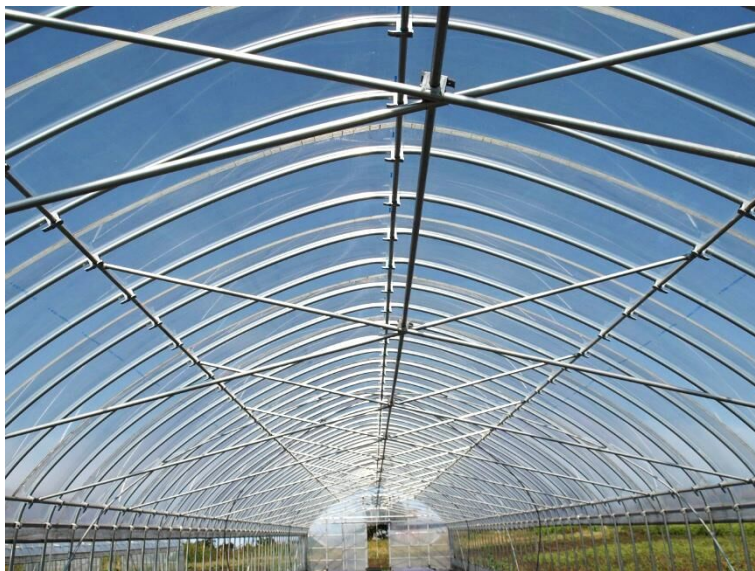
図8 Xタイバーによる補強の事例
