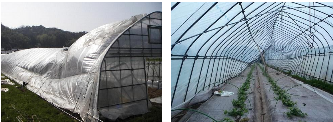
図18 強風によるパイプハウス倒壊事例（鳥取県農業共済組合）
