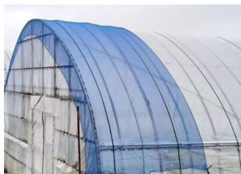
図26 妻面の防風ネットによる補強
