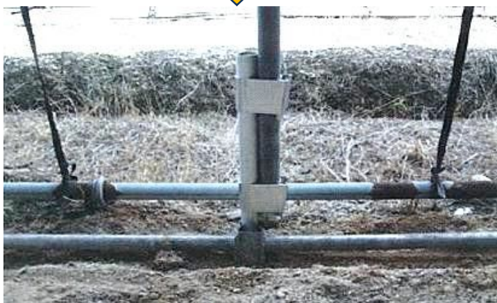
完成した補強
