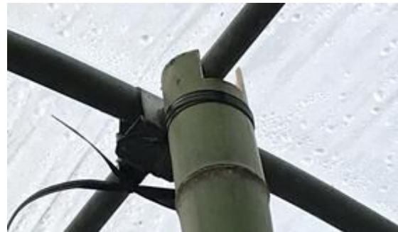
図14 中柱先端の加工と固定
