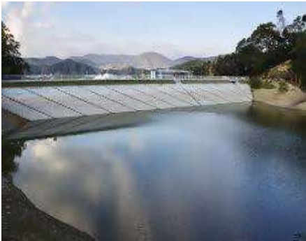
ため池の改修
