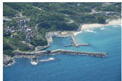
漁港施設の改修（夏泊）
