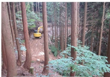
(作業道の作設作業中)
