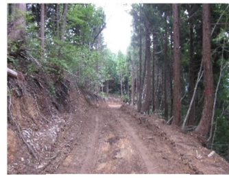
(作設後の作業道)
